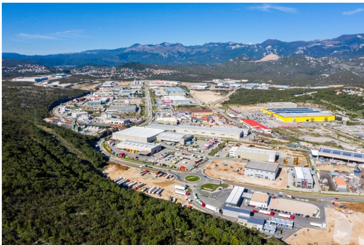
Slika 4. Industrijska zona Bakar
